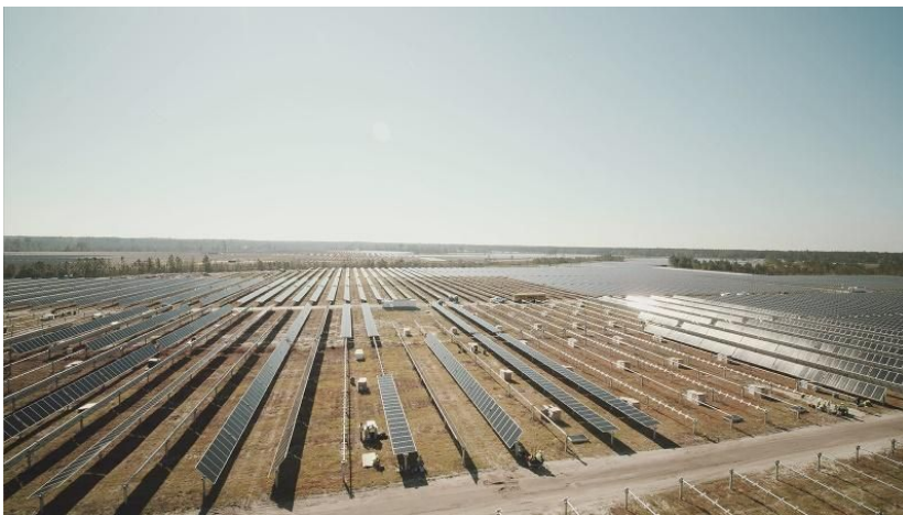
Fazenda solar com painéis fotovoltaicos produzidos com polímero especial
